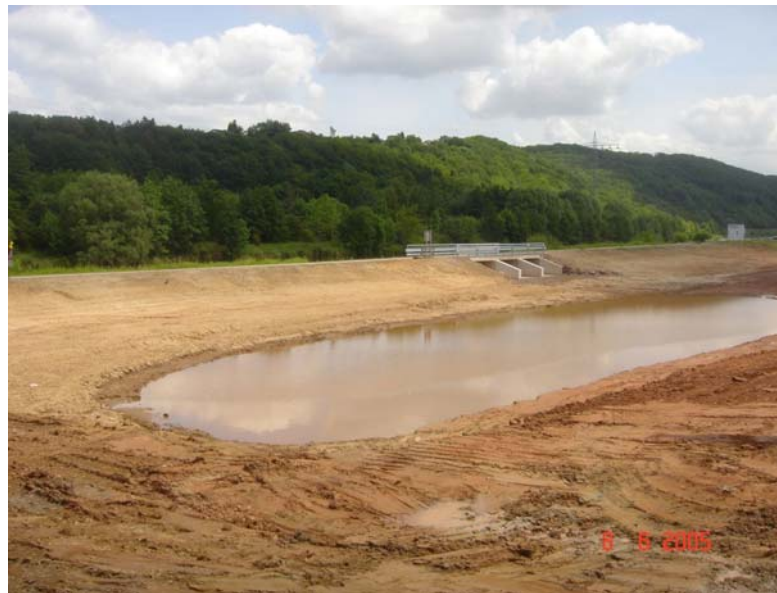
Teil der Abgrabungsfläche linksseitig der Saar bei Wadgassen-Hostenbach mit Einlauf-/Auslassbauwerk zur Saar
