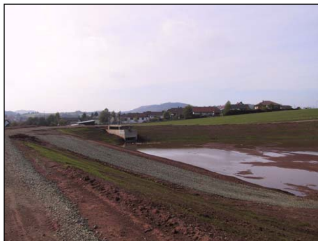
Das Rückhaltebecken am Frohnbach kurz vor der Fertigstellung
