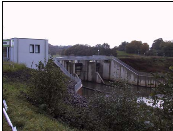
Regel und Entlastungsbauwerk des Hochwasserrückhaltebeckens von Ottweiler
